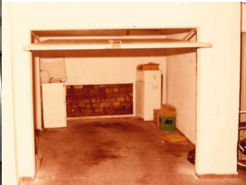
13)- Ripresa dell'interno del box; -
